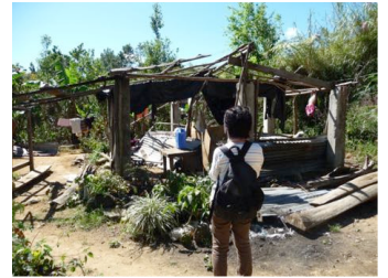
台風被害に遭い、柱だけ残った家
